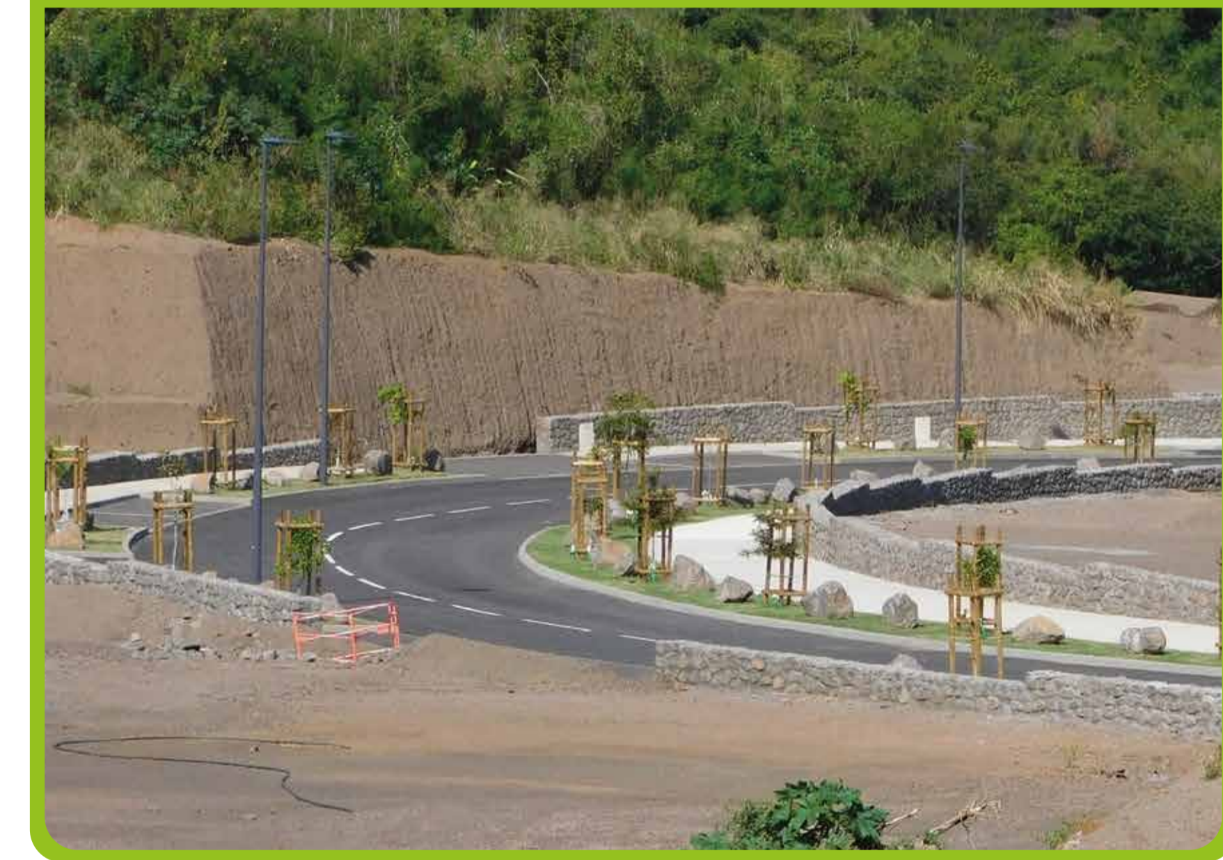
Travaux d'extension de la Zone Industrielle n°4
