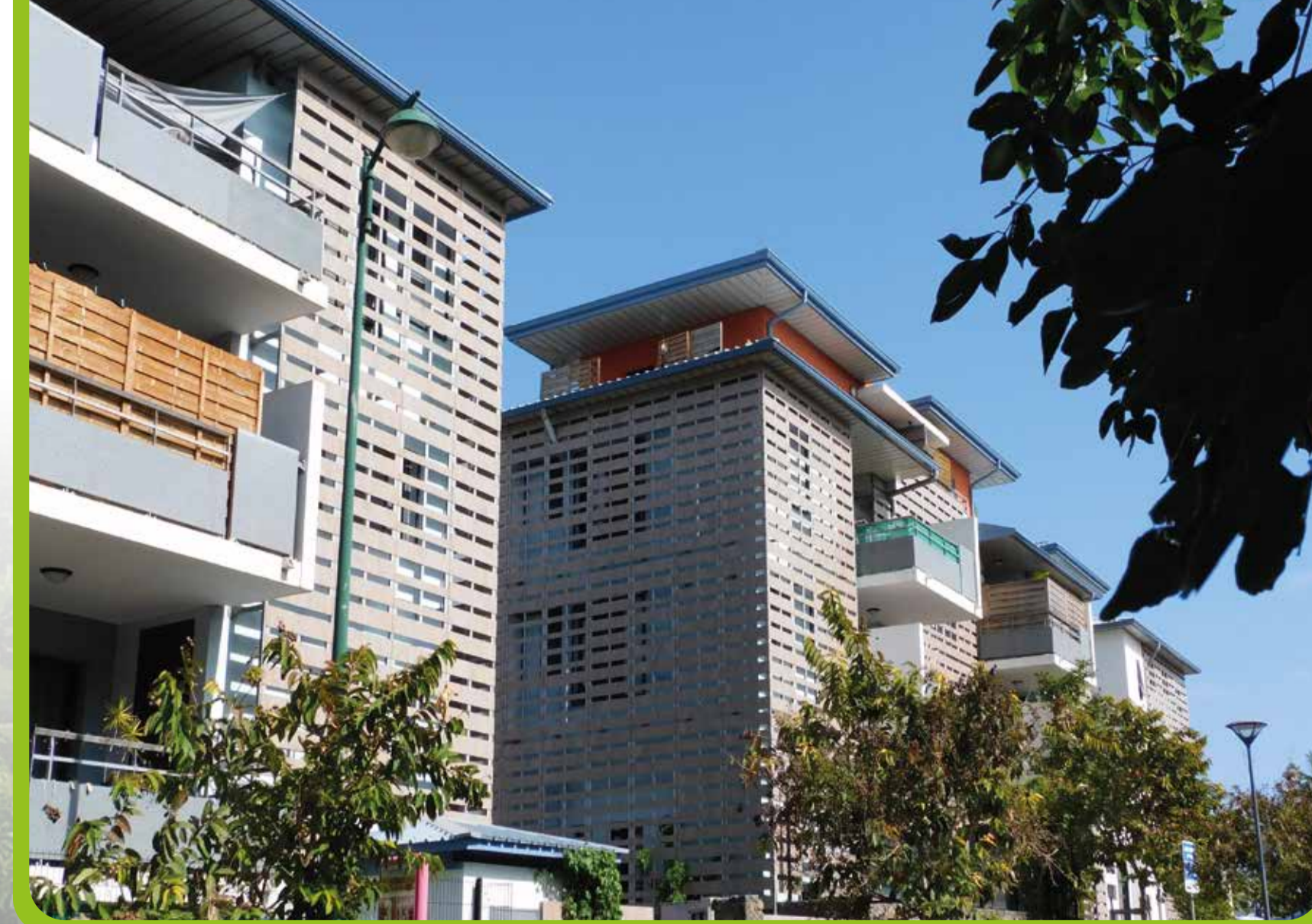
Opération de logements sur Bois-d'Olives
