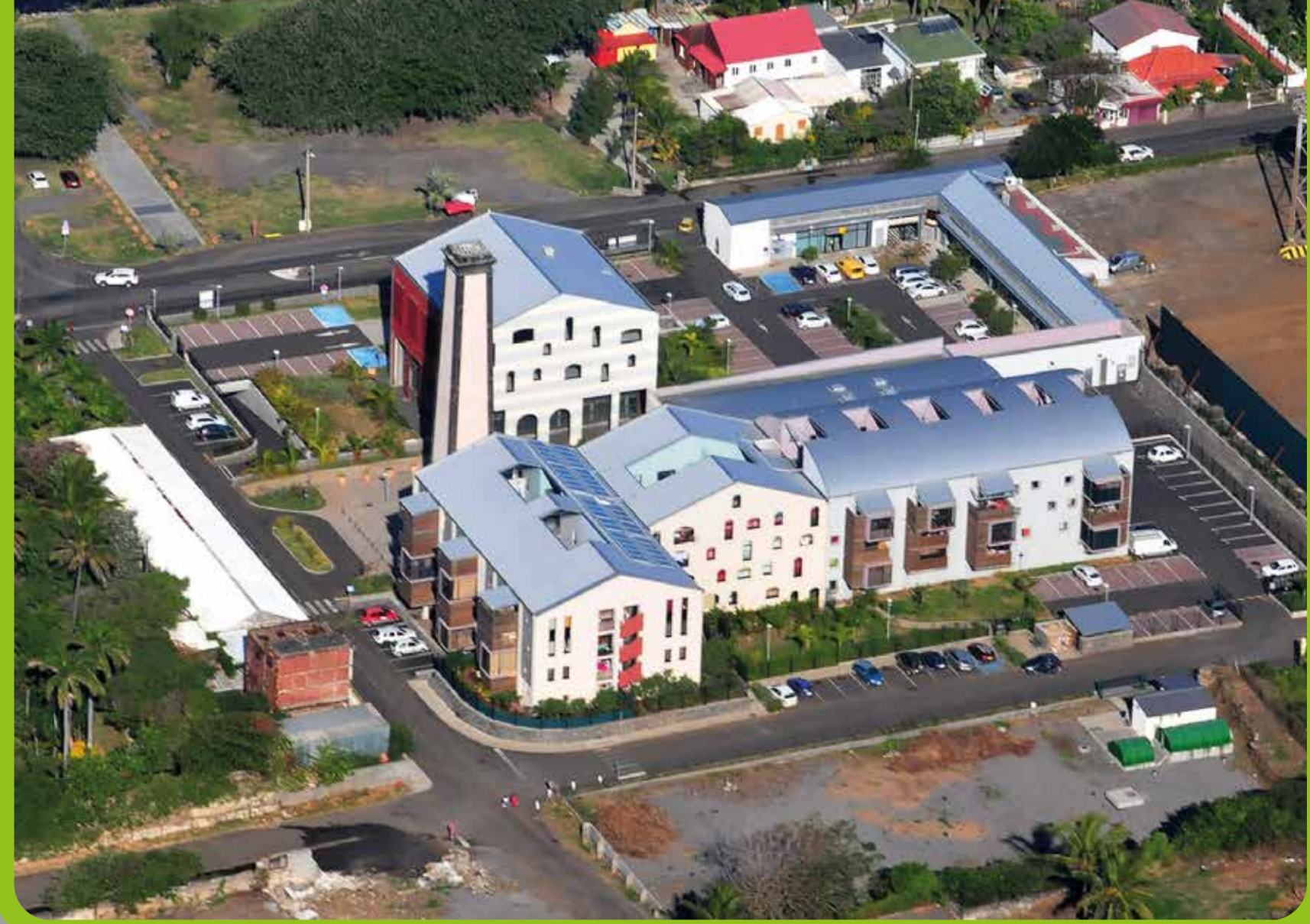
Réhabilitation usine de Grand Bois
